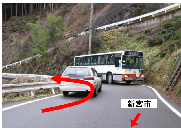
線形不良箇所 (大塔町閉君地内)
