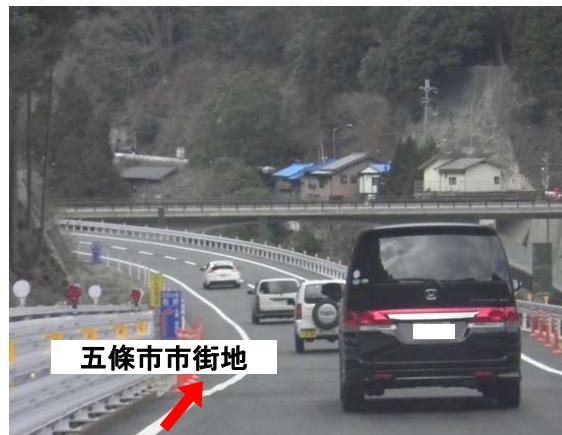
H23紀伊半島大水害により暫定供用した区間 (大塔町辻堂地内) ※平成26年12月26日に現道に切替
