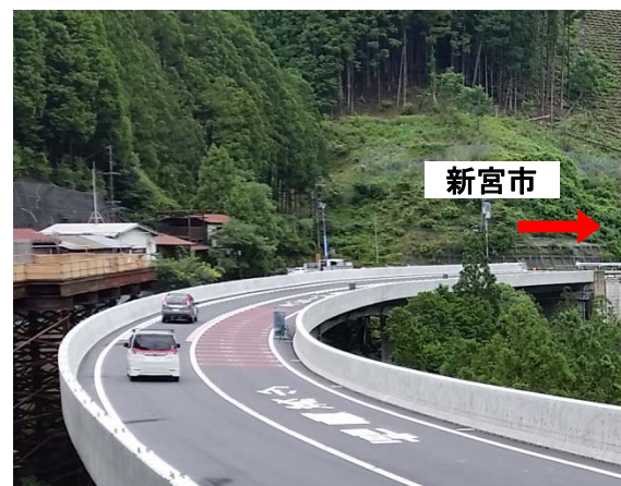
線形不良が解消された区間 (大塔町閉君地内) ※平成27年7月10日に切替
